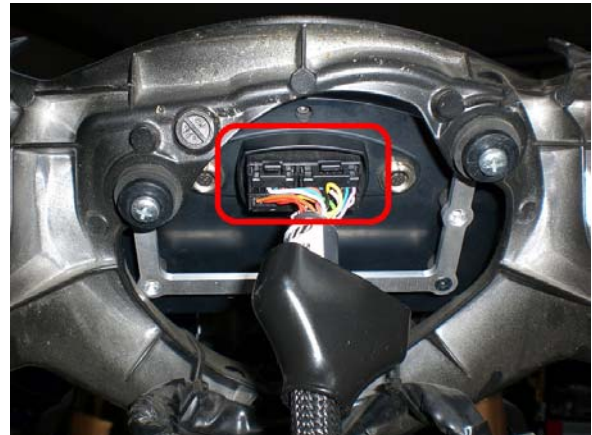
Figura 10 : Connessione del cablaggio di MXL.
